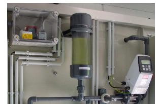
Abb. 4: Ansaughilfe, Pulsationsdämpfer und IDM
