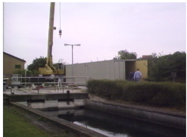
Abb. 1: Lager- und Dosierstation Typ LD22/T – Absetzen der anschlussfertigen Anlage mit Hilfe eines Autokranes.
