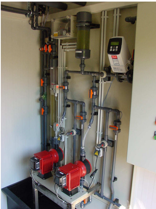
Abb. 2: Dosiereinheit der Lager- und Dosierstation Typ LD22/T
