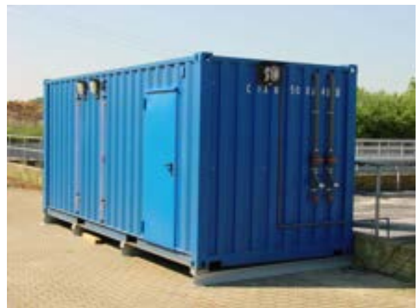
Abb. 1: Lager- und Dosierstation (Typ LD11/T) – an der Vorderseite sind die Befüllleitungen für die Lagerbehälter, die optischen und akustischen Warneinrichtungen sowie die Dosierleitung zu erkennen. Auf der linken Seite befinden sich neben der Eingangstüre die Füllstandsanzeigen der Lagerbehälter.
