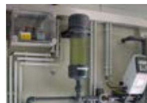
Abb. 4: Ansaughilfe, Pulsationsdämpfer und IDM
