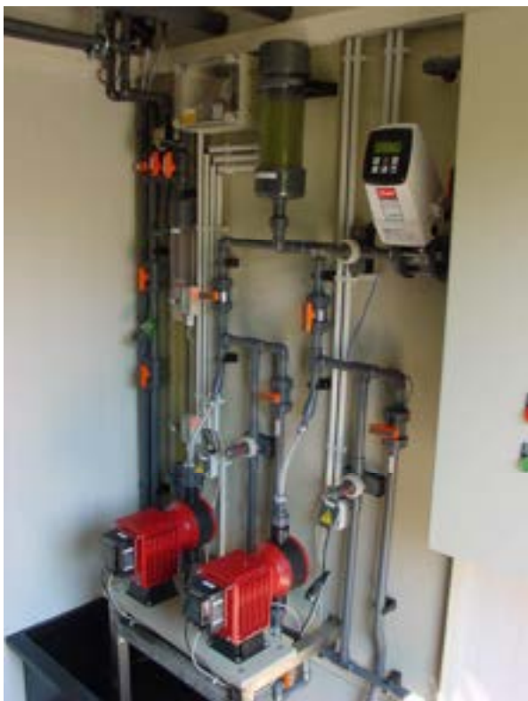
Abb. 2: Dosiereinheit der Lager- und Dosierstation Typ LD5/T
