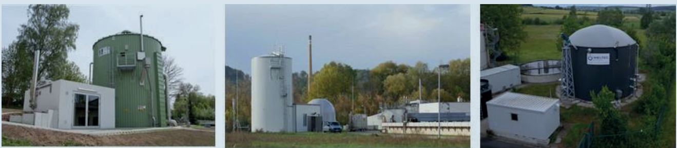
Bild 9: Beispiel kleiner Faultürme: KomBio-Reaktor (Faulbehälter und Gasspeicher in einem) mit 200 m 3 Faulvolumen – Lipp GmbH[9] (links), Arequa GmbH [10] (Mitte), Weltec Biopower GmbH [11] (rechts)
